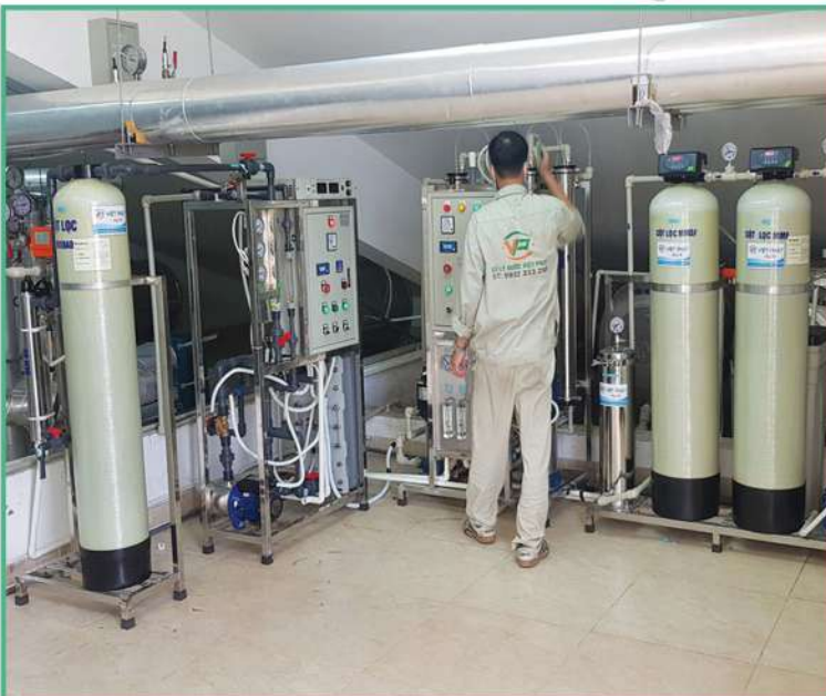
Công trình: Hệ thống lọc siêu tinh khiết RO + EDI + Mixbed, công suất 250l/h, đạt 15-18megaohm/cm Khách hàng: Viện Ứng dụng Công nghệ - Bộ KH và CN - KCN cao Hòa Lạc, Thạch Thất, Hà Nội
