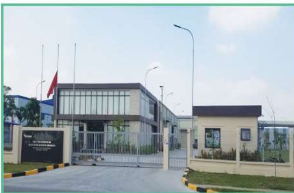
Công trình: Hệ thống lọc nước siêu tinh khiết RO 2 cấp + DI, công suất 3m3/h Khách hàng: Công ty Vinafoam - KCN Vsp, Cẩm Giàng, Hải Dương
