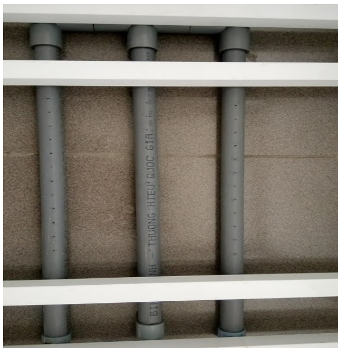
Hình 3.2 Giàn mưa.
